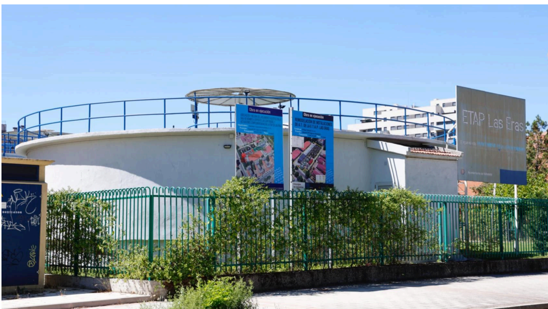
ETAP depuradora Las Eras
