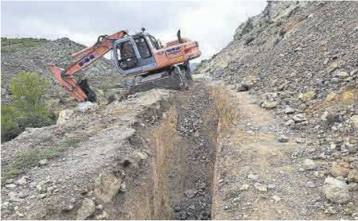
Obras de canalización en la zona.
