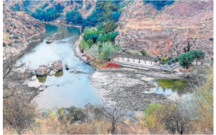
El Tajo lleno de piedras a la altura del azud de Romalia hacia el de Santa Ana
